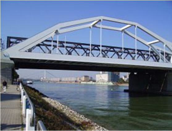
Puente fabricado de acero
